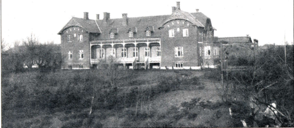
Det nye stuehus til Grønvang. Det blev bygget i 1894 af Johannes Lauridsen og kostede den formidable sum af 21.000 kr.
