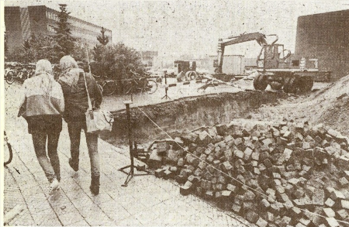
Pladsen foran hotellet er opgravet nu, idet kloakken skal lægges om.
